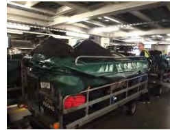
Flughafen DUS – Gepäcksortieranlage
